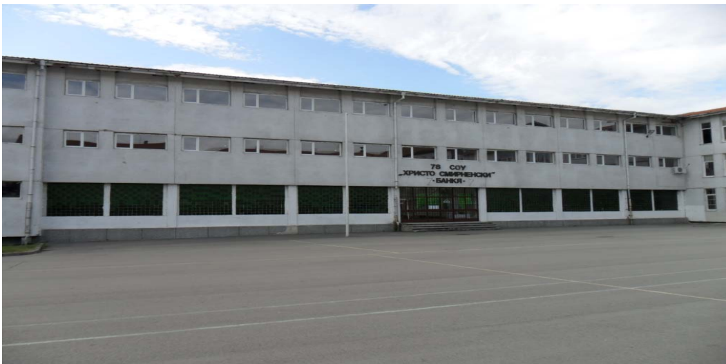
Abbildung 1 zu sanierende Schule nahe Sofia
