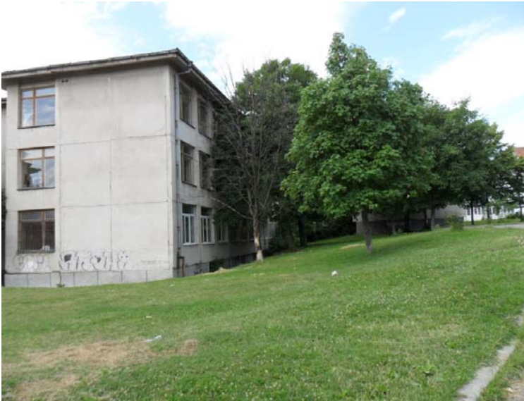
Abbildung 2 zu sanierende Schule nahe Sofia
